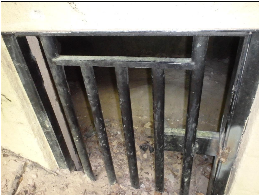
Foto 19. Mõnede avade puhul on loobutud lukustamisest ja kasutatakse keevitamist, st kord aastas, kui nahkhiiri seiratakse, lõigatakse keevitus lahti ja pärast keevitatakse jälle kinni. Foto: Lauri Klein.
