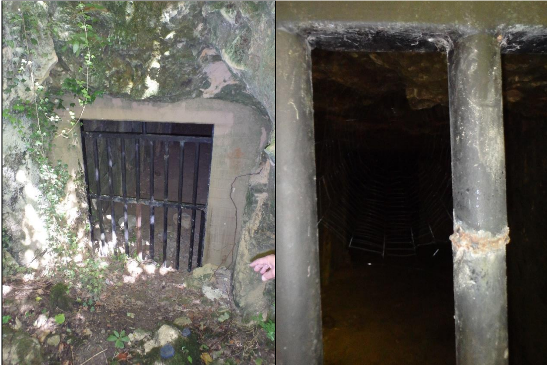
Foto 18. Väiksemate avade trellid. Pea kõikjal oli märke trellide lõhkumisest ja parandamisest. Vasakpoolsel fotol on näha ka et vertikaalse trellistiku ülaossa on jäetud horisontaalsed lennuavad nahkhiirtele. Foto: Lauri Klein.
