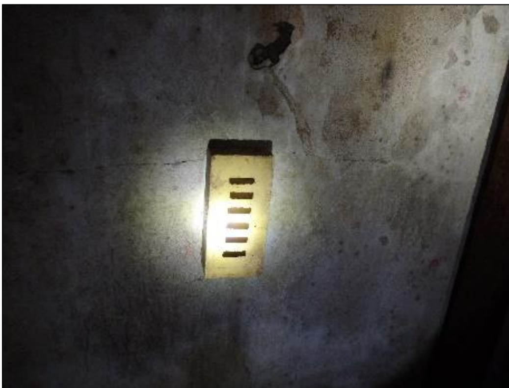
Foto 24. Üheks võimaluseks nahkhiirtele varjepaikade tekitamisel on avadega tellised. Foto: Lauri Klein.
