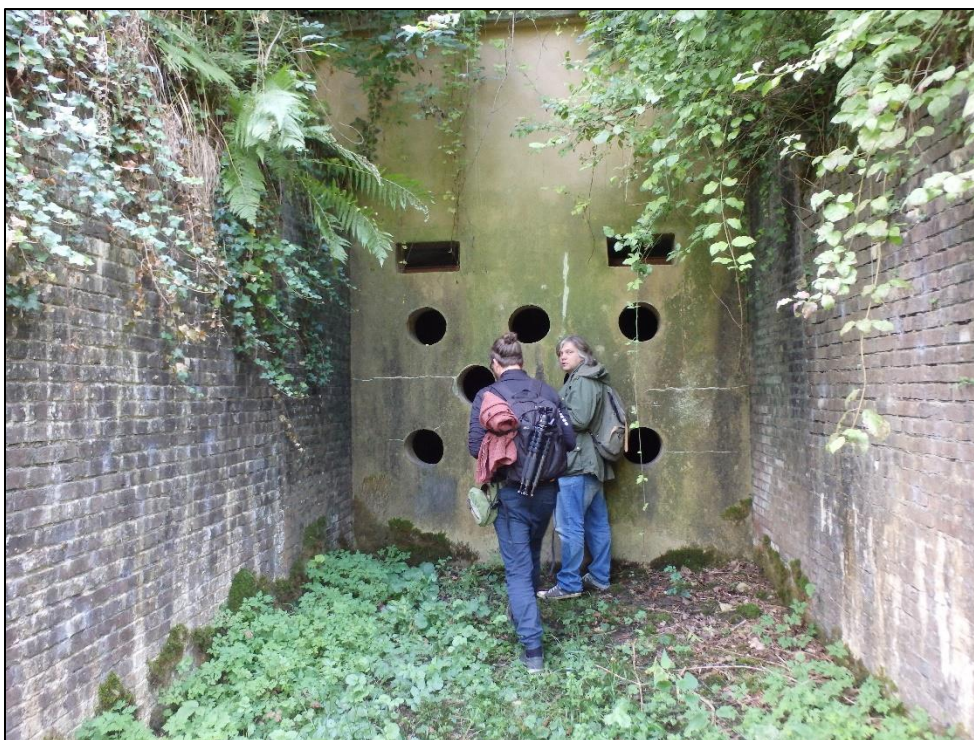
Foto 20. Leidus ka sissepääse, mis olid suletud betoonseinaga, millesse olid jäetud lennuavad. Üldiselt aga pidid sellised lahendused muutma tunnelite sisekliimat ja ka nahkhiireuurijatel puudub sellistesse kohtadesse ligipääs. Foto: Lauri Klein.
