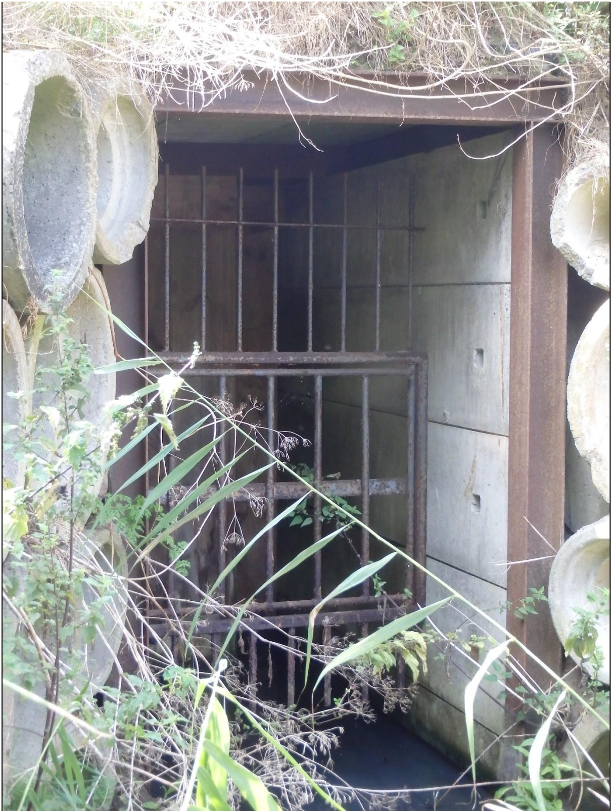
Foto 4. Trellitatud punker Slootdorpi lähistel, kus on kasutatud nii veetõket kui ka vertikaaltrelle. Hollandlaste jutu järgi on see hea kombinatsioon. Foto: Lauri Klein.
